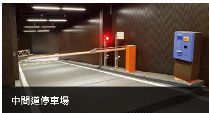
安裝停車場系統
