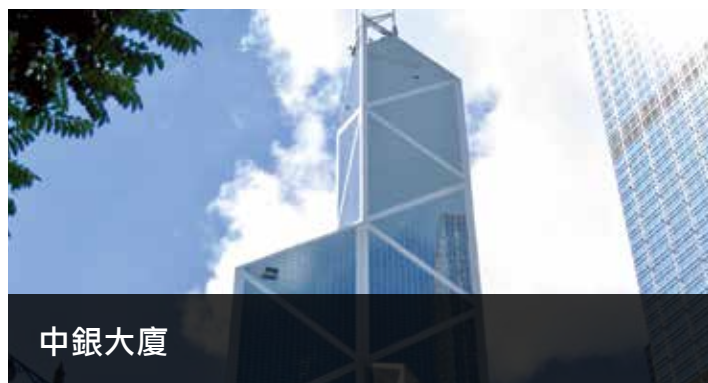
安裝停車場系統
