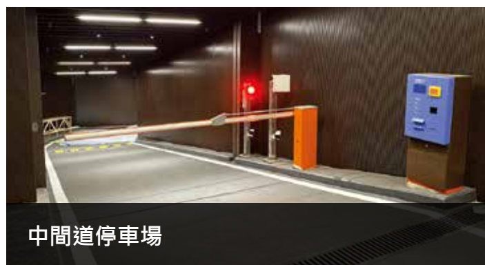
安裝停車場系統
