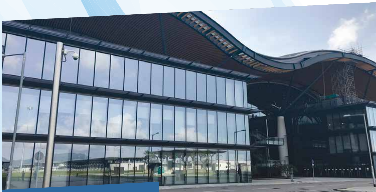
港珠澳大橋（香港口岸）
